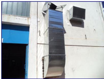
Слика 38 Вентилациоина кутија компресор
