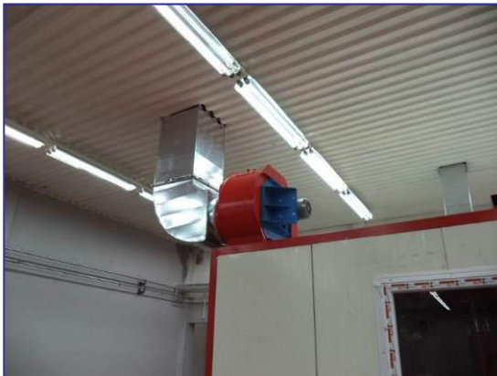
Слика 22 Вентилациона кутија на кабина
