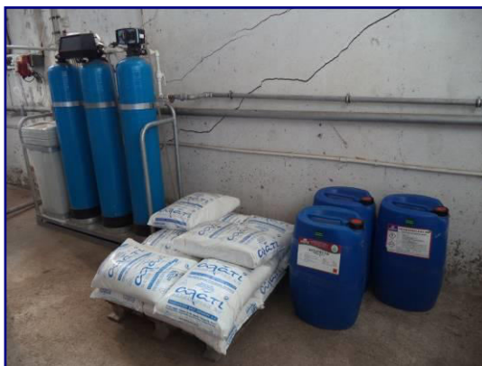
Слика 25 Систем за омекнување на водата
