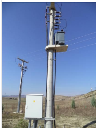
Слика 4 Трансформаторска станица
