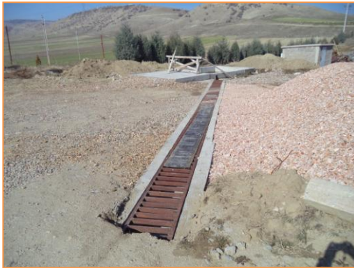
Слика 16 Бетонски канал
