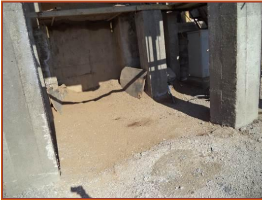
Слика 15 Бетонска платформа
