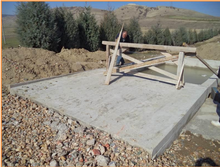
Слика V.3 Приеман таложник со резервоар
