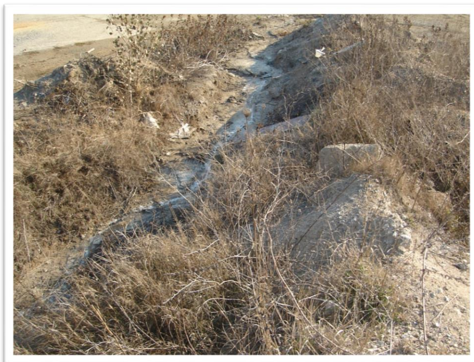
Слика 1 Земјен канал за прифаќање на отпадна вода од бетоњерката
