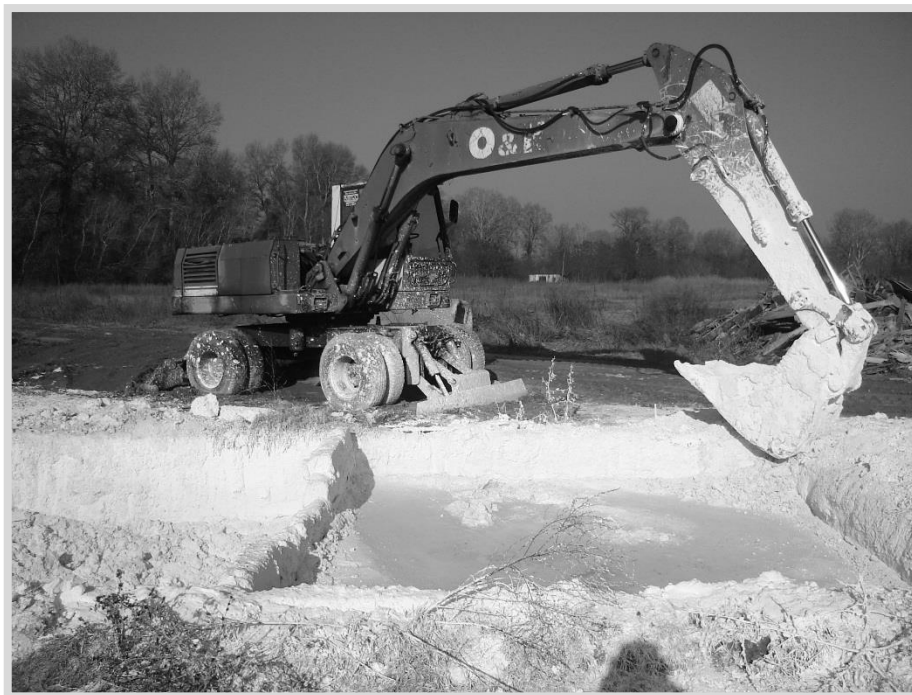
Слика 3 Складирање на гасена вар во јама
