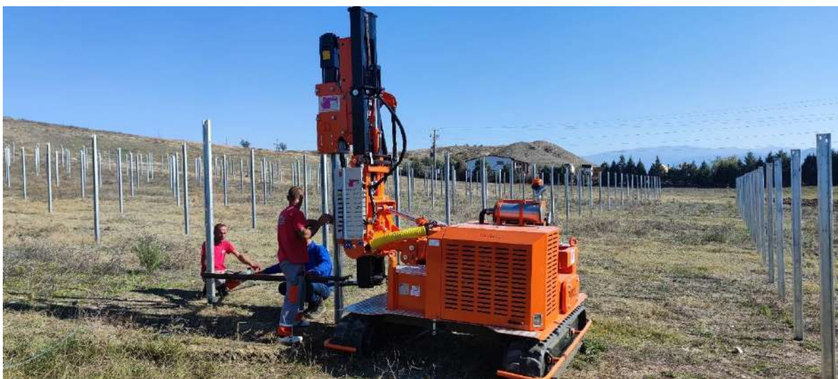
Монтажа на конструкцијата на фотонапонската централа
