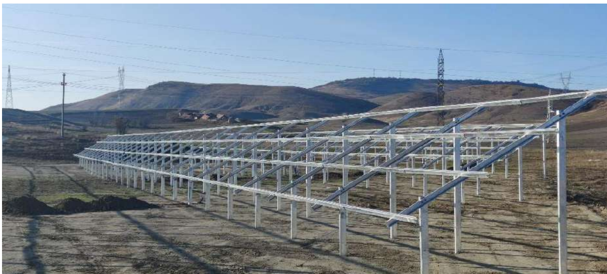
Монтажа на конструкцијата на фотонапонската централа
