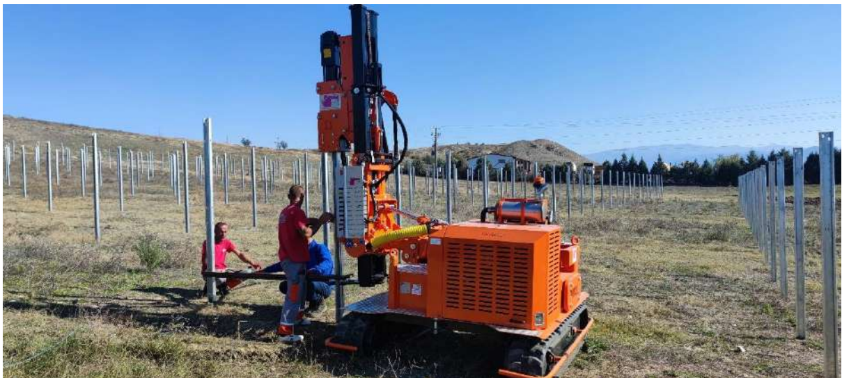
Монтажа на конструкцијата на фотонапонската централа
