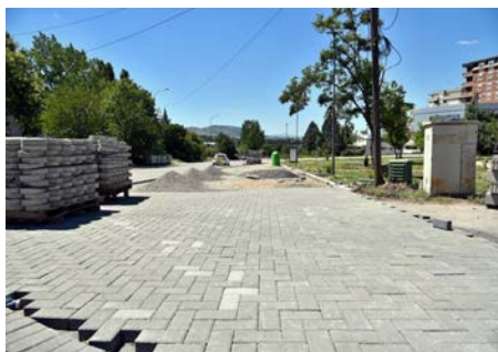
Реконструкција на тротоар во населба Сењак 2
