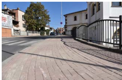
Реконструкција на тротоар кај црква Св.Никола
